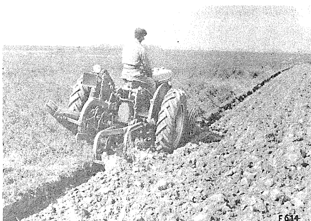
CHARRUE ALTERNATIVE FU-122 PORTEE SUR UN UTILITY EQUIPE DE L'ARBRE ARRIERE DE RELEVAGE ARTICULE
