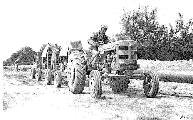
L'UTILITY CONVIENT NON SEULEMENT AUX TRAVAUX AGRICOLES MAIS AUSSI AUX APPLICATIONS INDUSTRIELLES ET AUX TRAVAUX PUBLICS. CI-DESSUS UTILITY DEPLACANT DES POSTES DE SOUDURE LE LONG D'UN PIPE-LINE.
