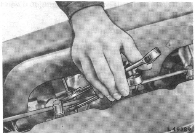
Fig. 4 — Serrage d'une conduite
